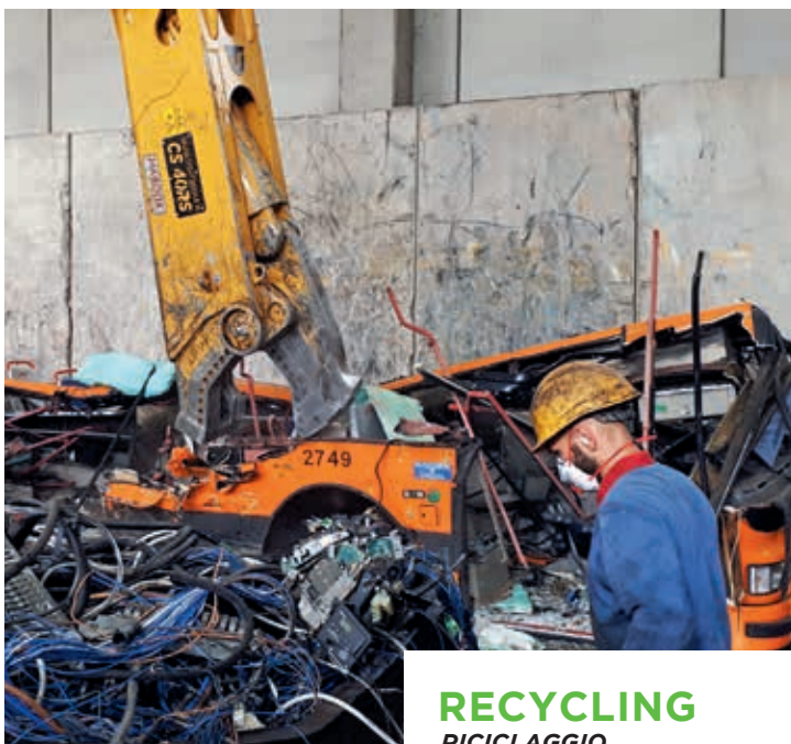
DEMOLITION DEMOLIZIONE DEMOLITION
